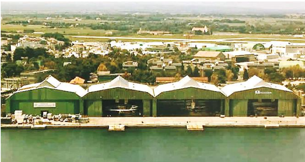
I 4 hangars Savigliano attualmente gestiti dalle Nazioni Unite
