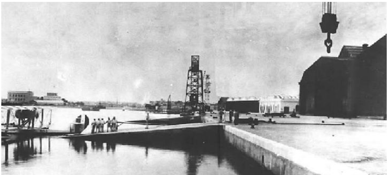
Rampe di scivoli all'Idroscalo di Brindisi - 1933
