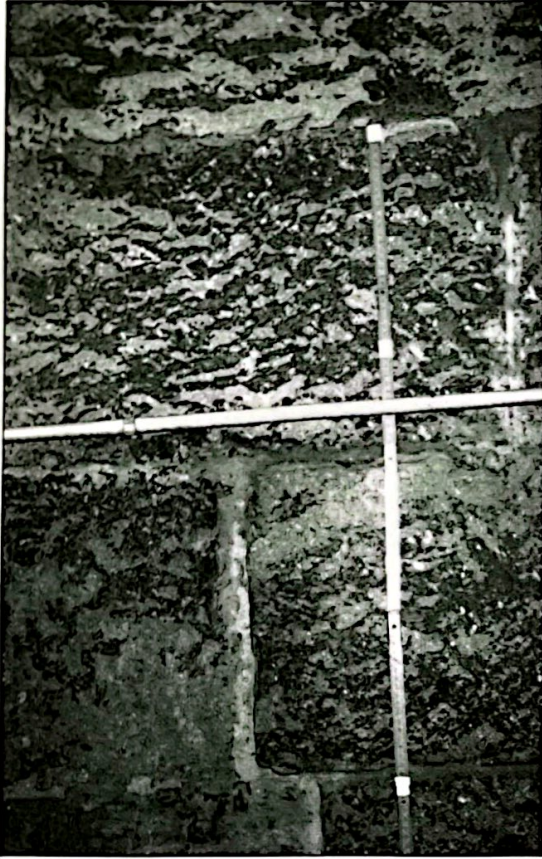
Fig. 3. Paramento murario federiciano nella torre quadrata di nord-est. Cat. 4.
