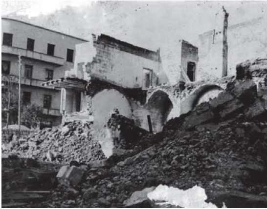
L'abbattiment della Torre dell'orologio
