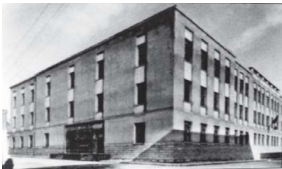
Scuole elementari Costanzo Ciano - 1939
