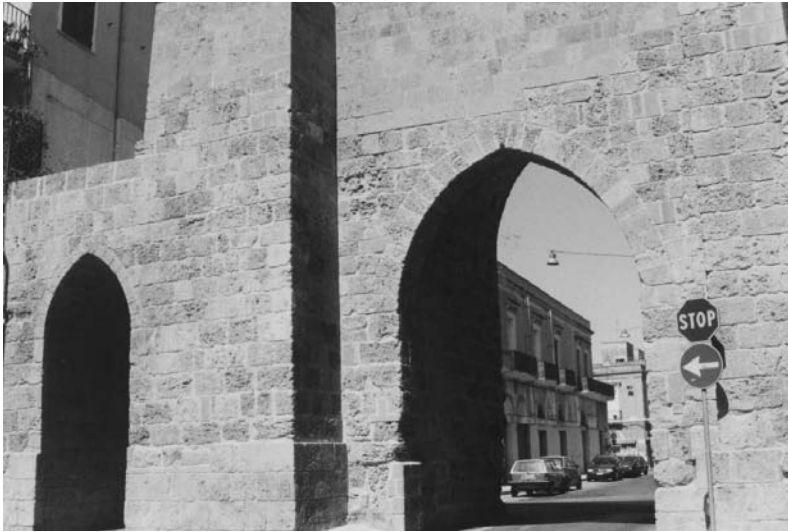
Fig. 43 - Brindisi. Porta Mesagne. La struttura dei varchi di età federiciana inglobata nelle murature quattro-cinquecentesche.
