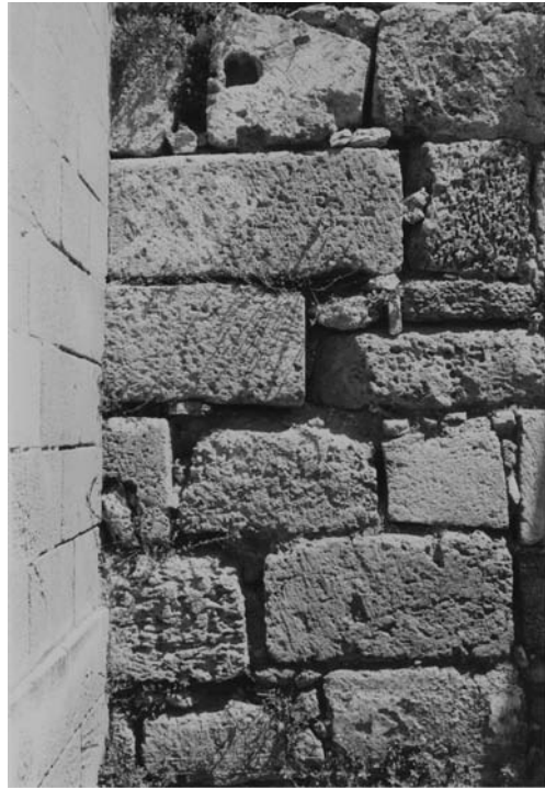
Fig. 23 c - Brindisi. Via P. Camassa, già rione Sciabiche. Resti della cinta muraria frontemare. Particolare del settore centrale. In evidenza blocchi con marchi lapicidi e fori di alloggiamento degli strumenti di sollevamento.
