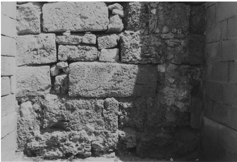
Fig. 23 a-b - Brindisi. Via P. Camassa, già rione Sciabiche. Resti della cinta muraria frontemare. In evidenza le diverse apparecchiature.
