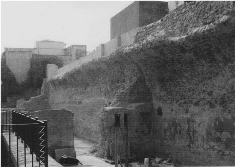
Fig. 5 - Brindisi. “Vasche limarie” dell’acquedotto romano.
