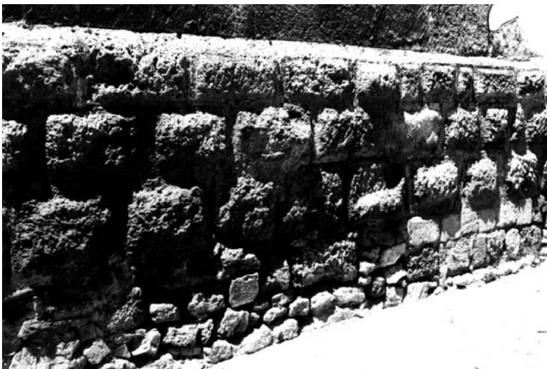
Fig. 35 - Brindisi. Chiesa di San Paolo. Vista del lato meridionale. Particolare dei filari basamentali a grande apparecchio bugnato, riferibili a strutture di età romana.
