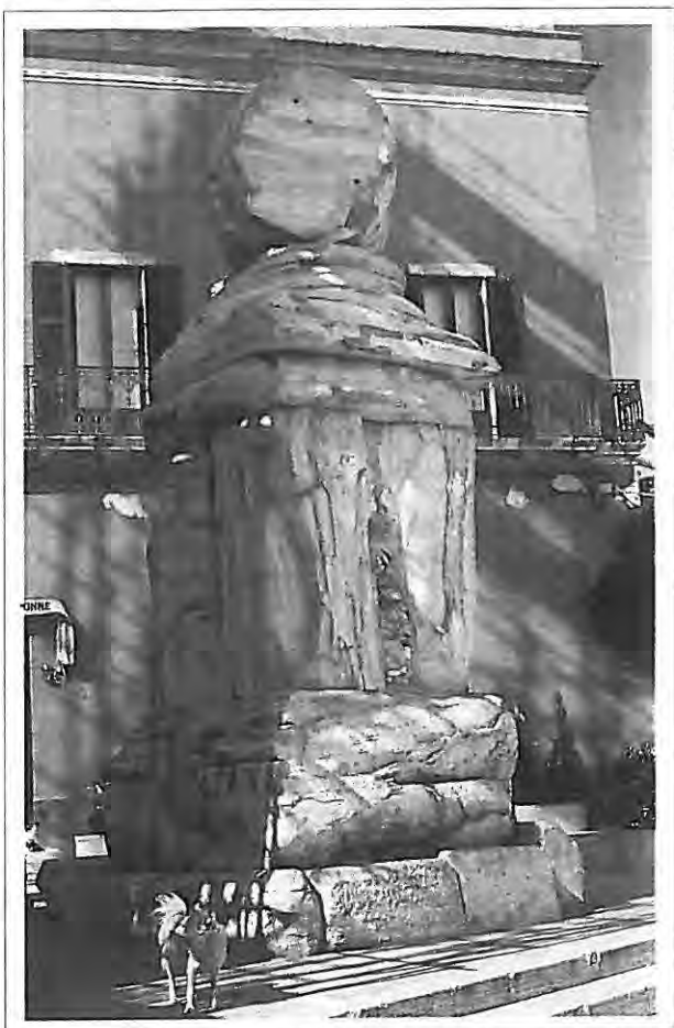
Base e rocchio della colonna nord-occidentale.
