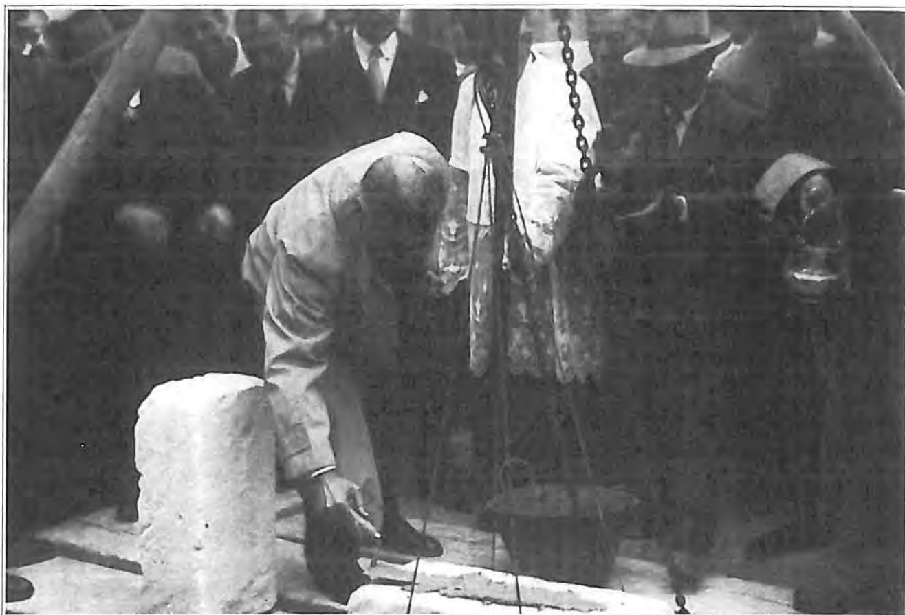
1948. Posa della prima pietra per l'erigendo edificio oggi sede del museo provinciale (Archivio Mariano, Brindisi).
