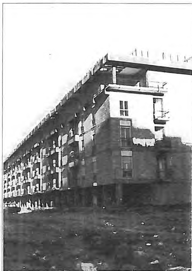
CARLO AYMONINO. Edificio in via Imperatore Costantino.
