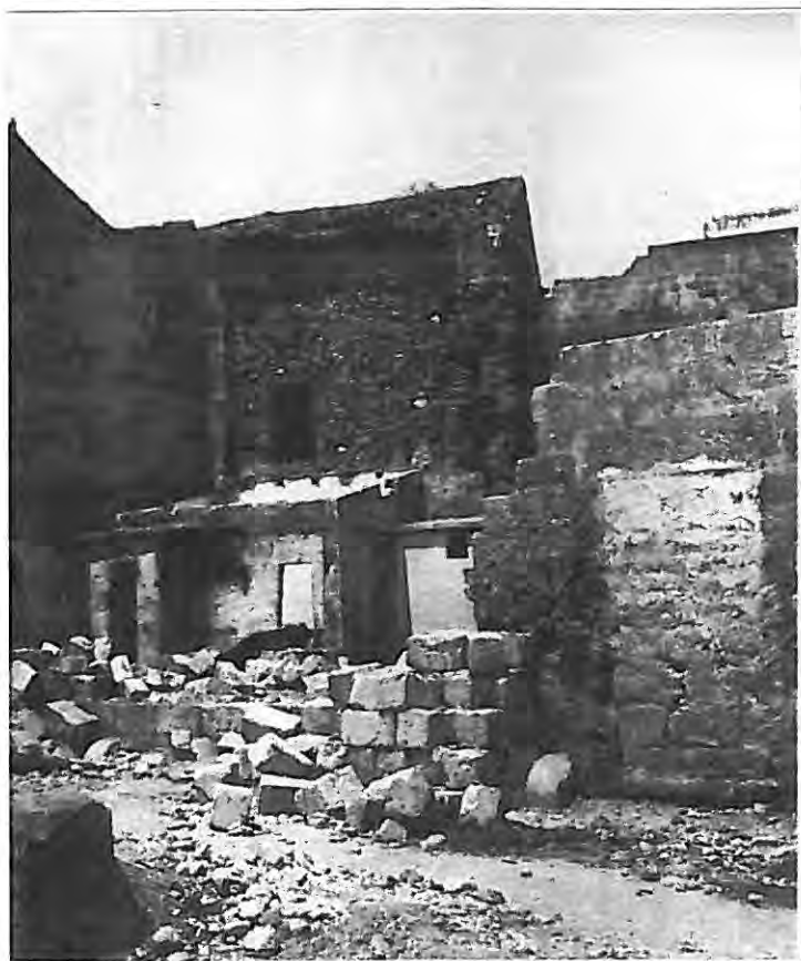
i Schiavoni. Le demolizioni (Fototeca Briamo, Brindisi).
