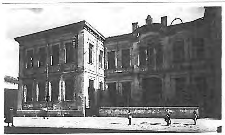
Palazzo delle Poste (Coll. La Valigia delle Indie, Brindisi).
