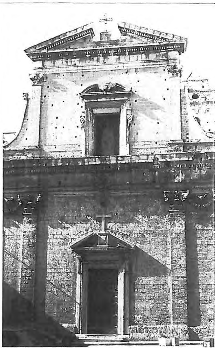
Santa Maria degli Angeli. Facciata.
