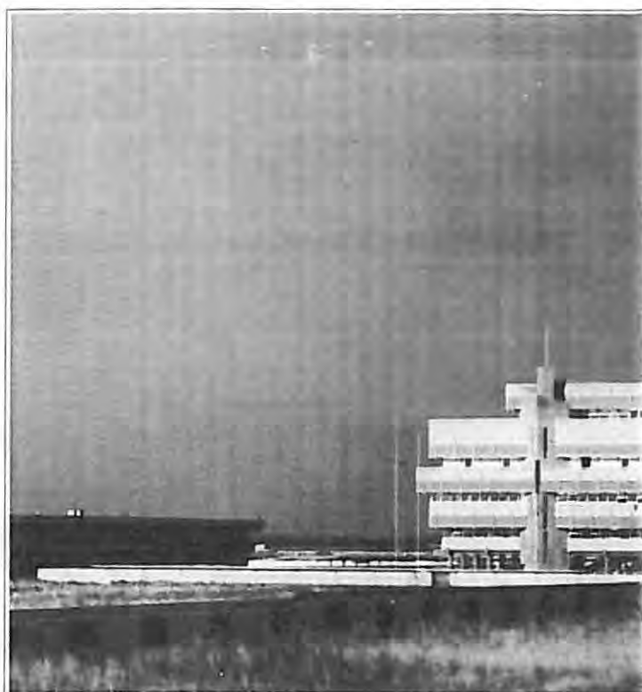
Petrolchimico Enichem. Fabbricato Uffici. Prospetto S.E. (Archivio E
