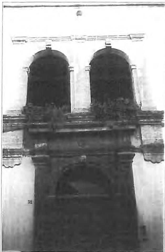
Palazzo Greco. Portale e loggia.
