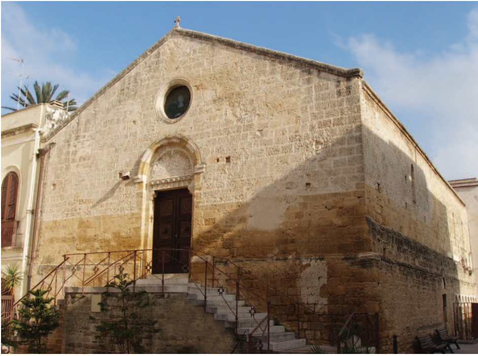
Fig. 1. Brindisi, chiesa della Santissima Trinità – Santa Lucia, esterno (foto dell'Autore).
