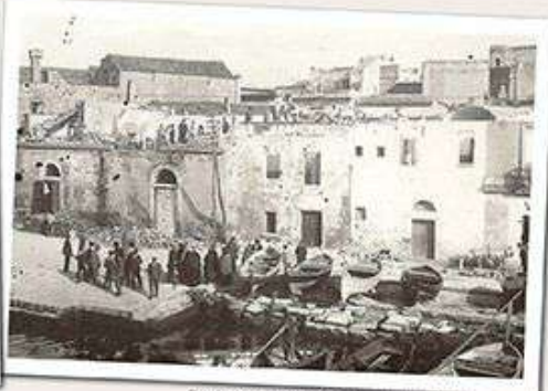
Sciabiche, Porto, prime demolizioni dei fabbricati
