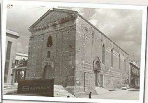
Chiesa di S. Paolo dopo le riparazioni. Foto 1968
