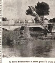
La banca dell'escavatore in alcune parti della strada sulla SS. 136
