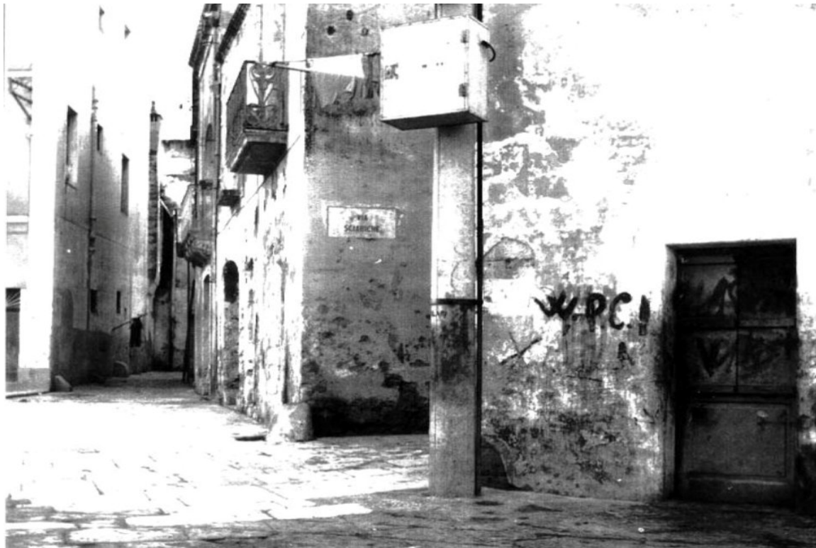
Via Sciabiche verso destra e Vico Capozziello al fondo
