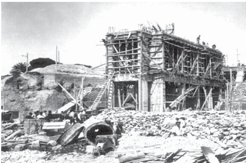
Le fasi iniziali della costruzione del Monumento
