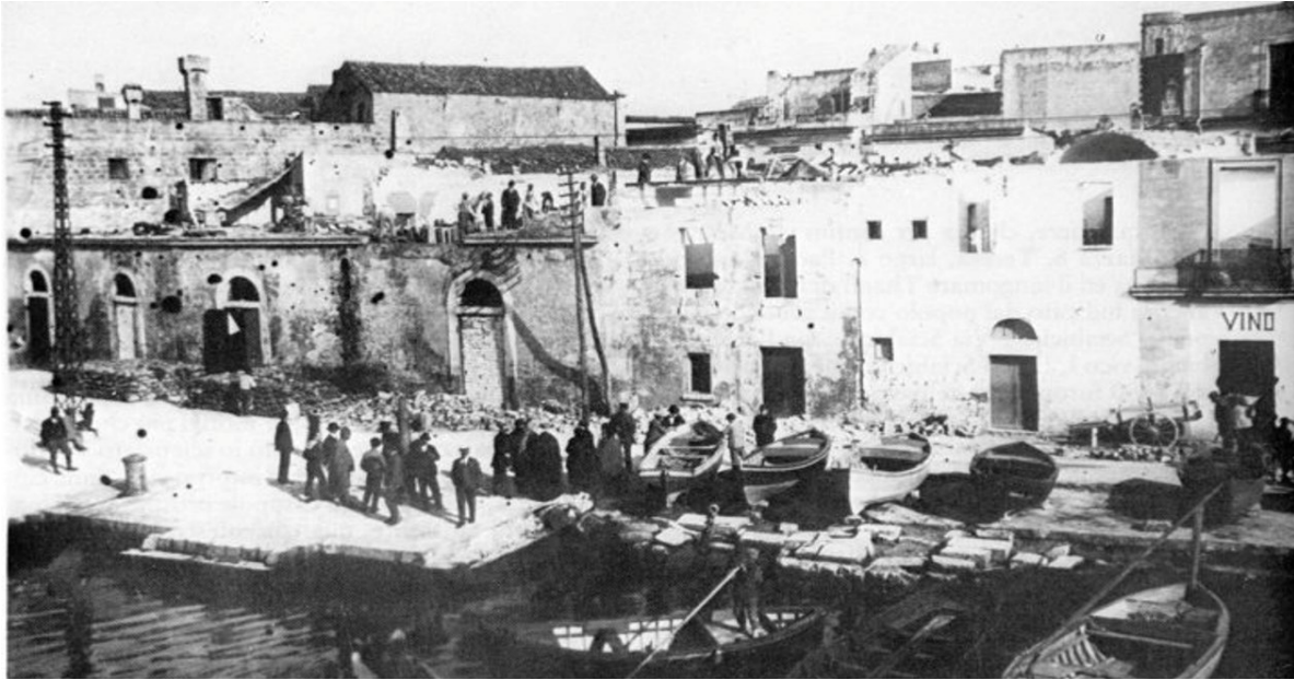
Quartiere Sciabiche: caseggiati alla vigilia della demolizione - 1924
