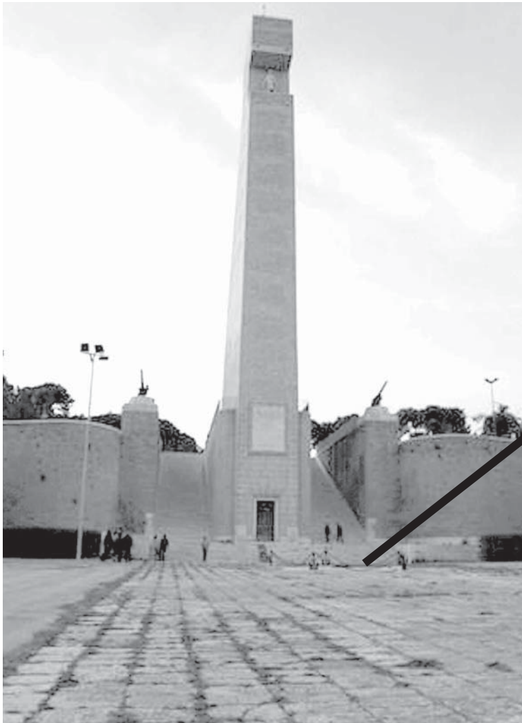
Il Monumento al marinaio. Sono ben visibili i ciuffi d'erba dovuti all'eccessiva umidità del sottosuolo. La freccia indica uno dei punti in cui si registra la tracimazione di acqua
