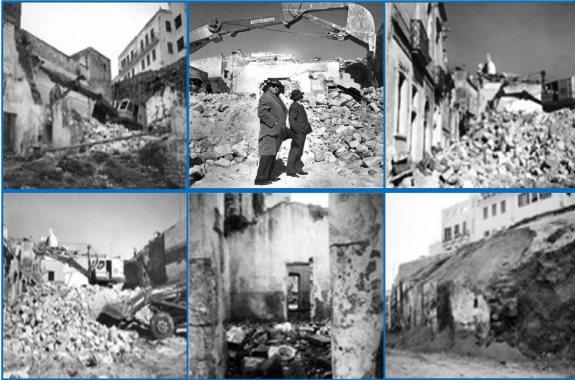
La demolizione delle Sciabiche: ultimo atto - 1959
