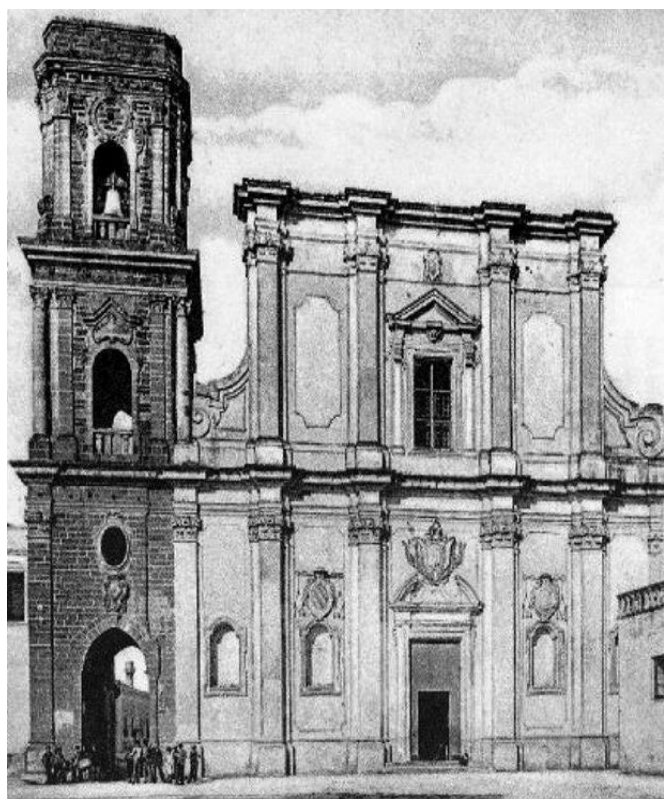
La Cattedrale di Brindisi Restaurata dopo il terremoto del 1743
