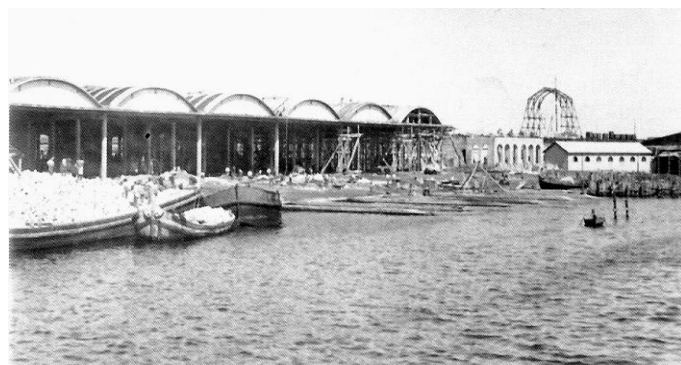
Hangars Bresciani per idrovolanti e hangar dirigibili In costruzione a Brindisi nel 1916
