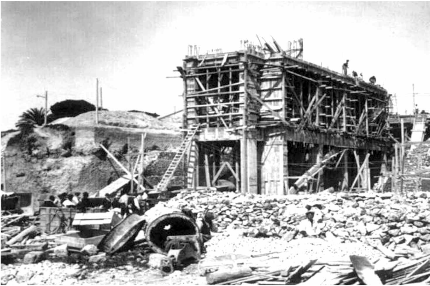
Le fasi iniziali della costruzione del Monumento
