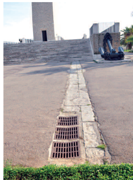
Sfoghi per l'acqua nei pressi del Monumento
