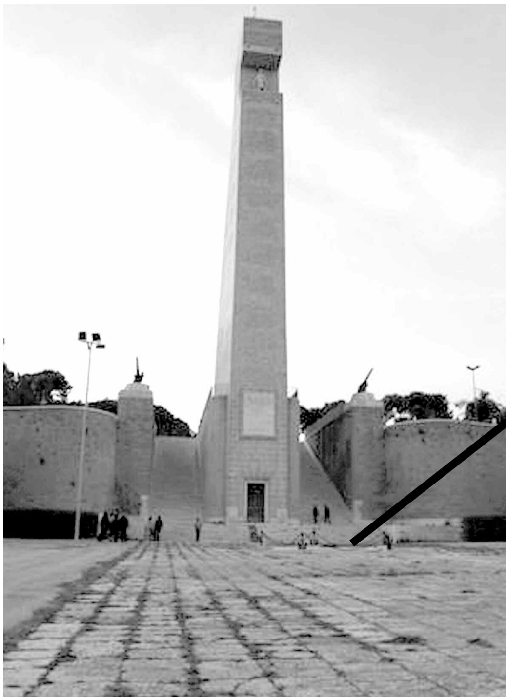
Il Monumento al marinaio. Sono ben visibili i ciuffi d'erba dovuti all'eccessiva umidità del sottosuolo. La freccia indica uno dei punti in cui si registra la tracimazione di acqua
