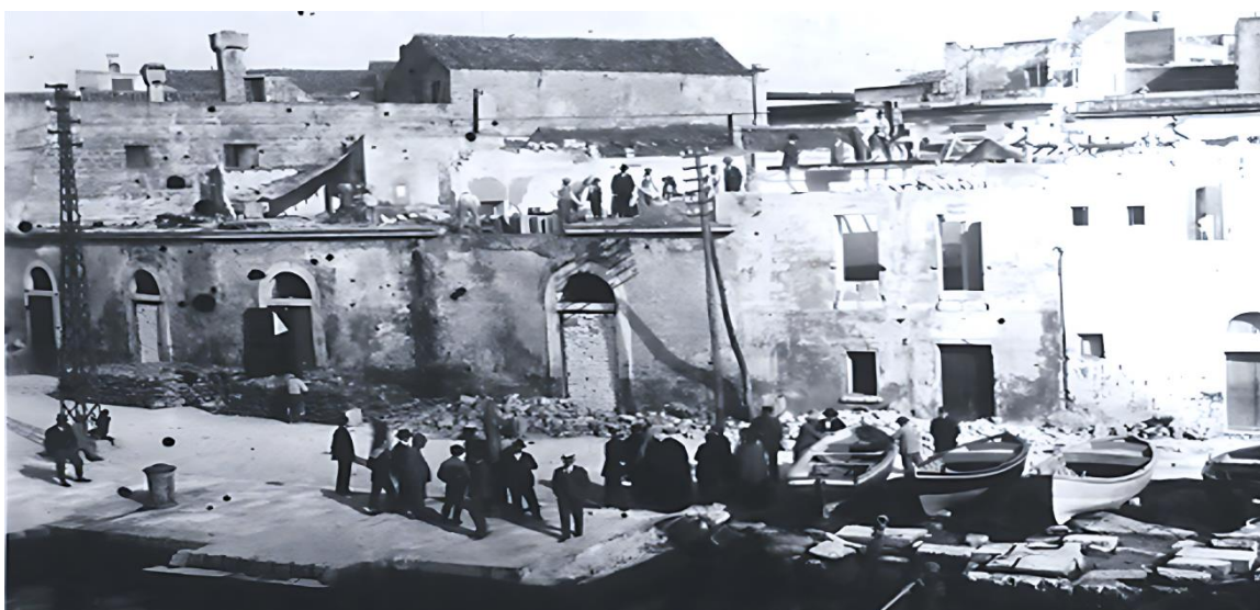
Fig.16: Prime demolizioni dei caseggiati sul lungomare - 1924 circa
