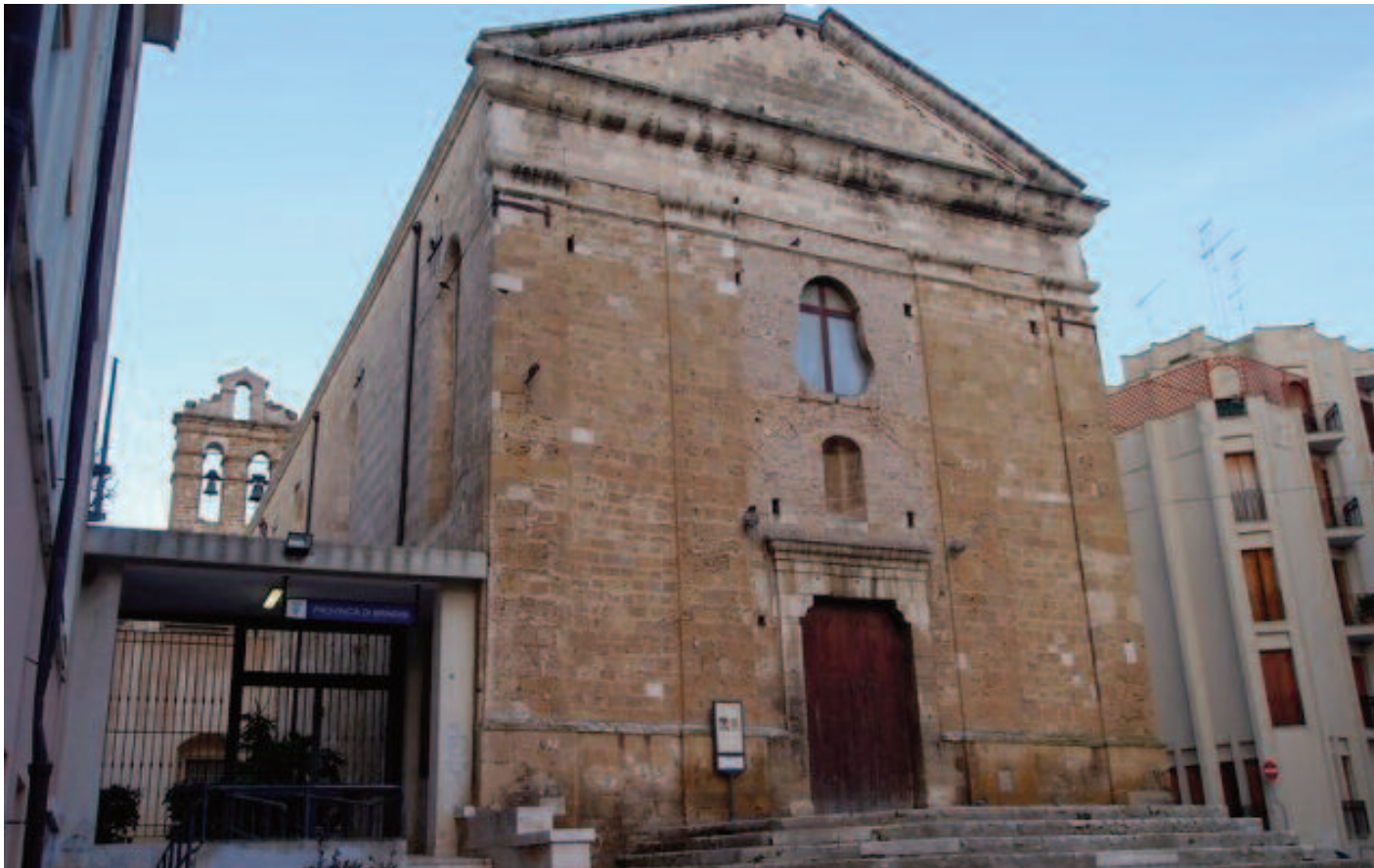
LE IMMAGINI La Chiesa di San Paolo Eremita - finita di costruire nel 1322
