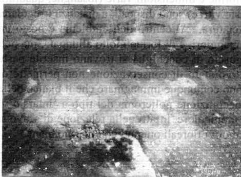
Fig. 3 - Pavimento C: cocchiopesto a scaglie
