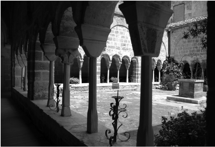
Fig. 20. Brindisi, monastero di S. Benedetto. Chiostro medievale (foto: Claudio Fornaro).
