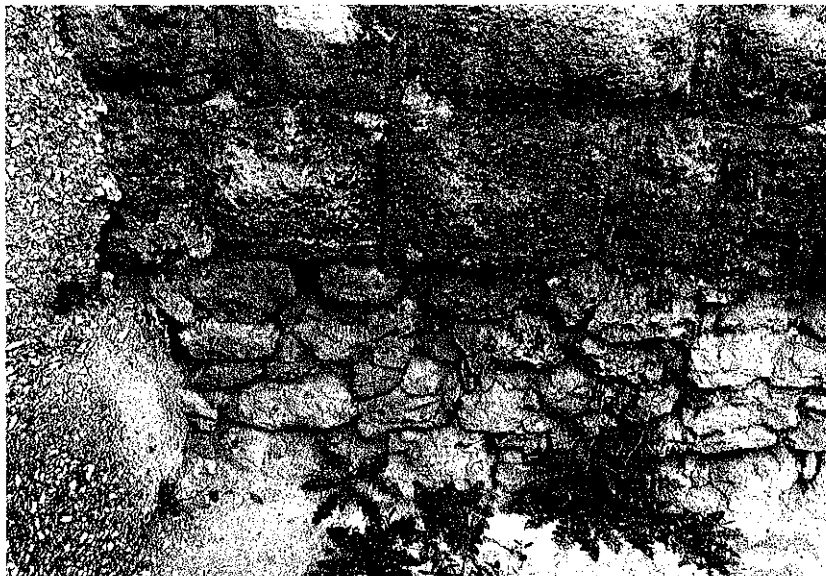
Fig. 6 - Frammenti del muro perimetrale della rocca in via De Vavotici. Foto dell'Autore©.
