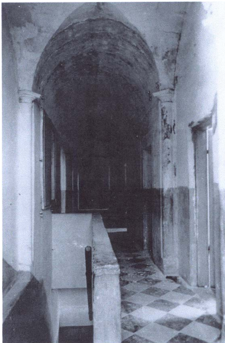
Foto n. 3 -Il corridoio del primo piano, con gli ingressi alle celle.
