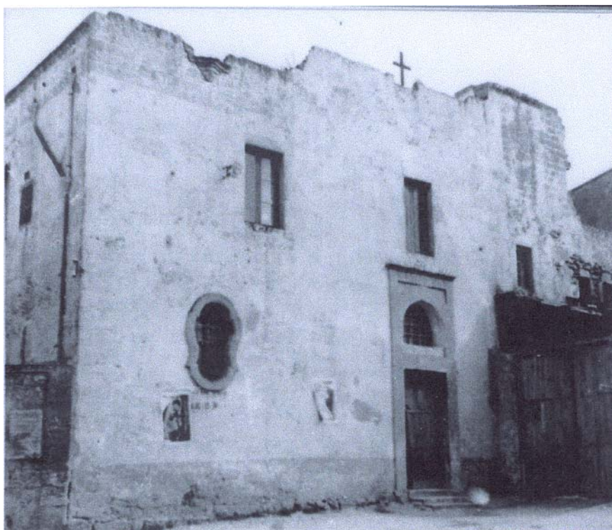
Foto n. 1 -La facciata prima dei lavori di restauro del dopoguerra
