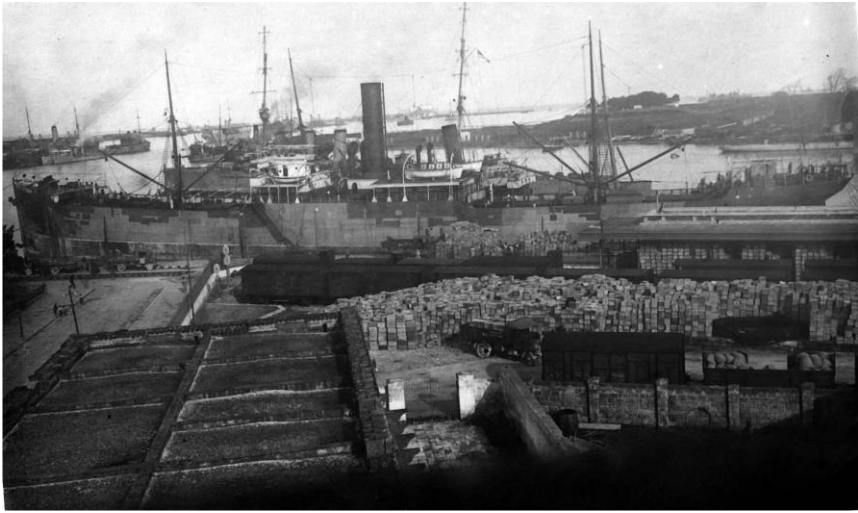
Fig. 14. Brindisi. Stazione porto. Rifornimenti da imbarcarsi per San Giovanni di Medua.
