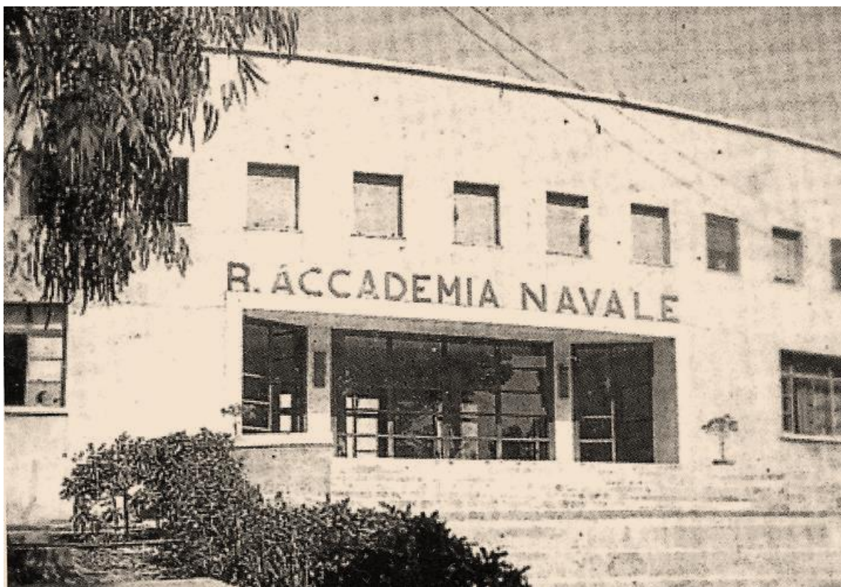
L'ingresso del Collegio Navale di Brindisi ai tempi dell'Accademia Navale: 1943-1946
