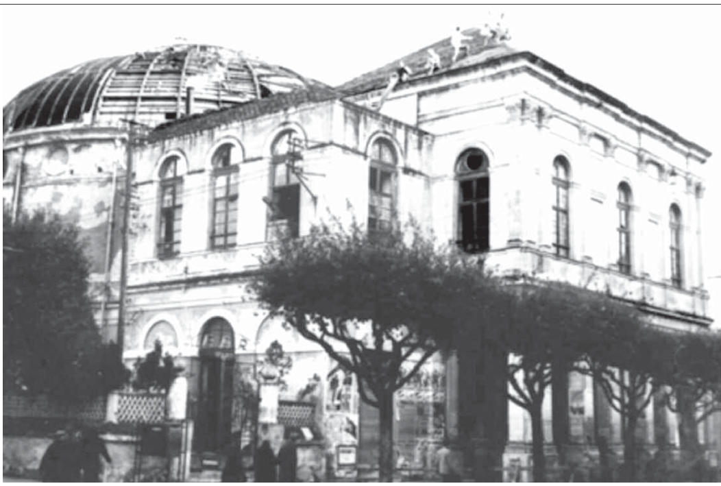
La demolizione del Teatro Verdi - 1960
