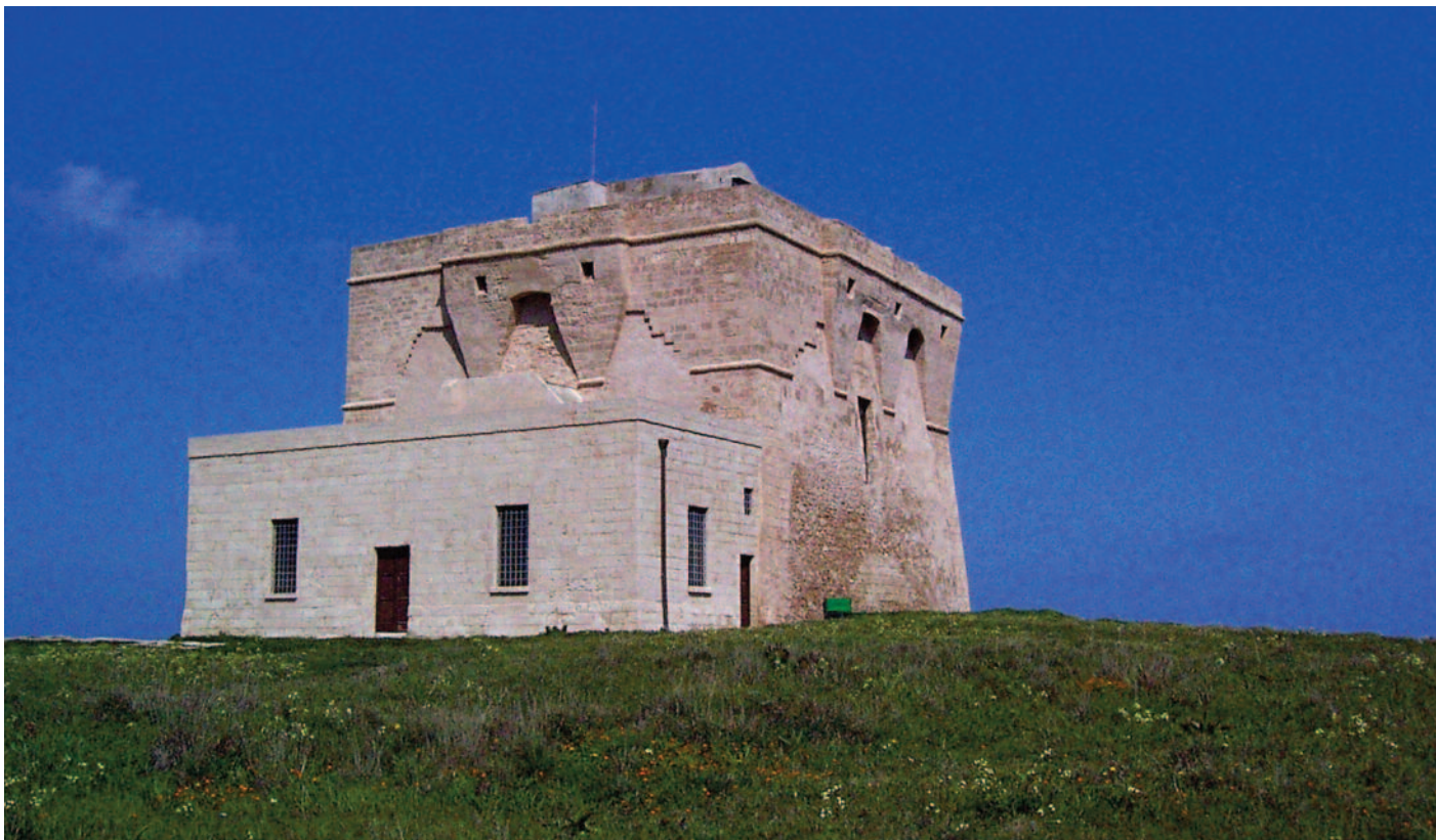
LE IMMAGINI Sopra in primo piano la costruzione posticcia addossata all'antica Torre Guaceto, sotto la nuova segnaletica che indica il percorso turistico delle torri costiere in cui viene indicata anche Torre Mattarelle
