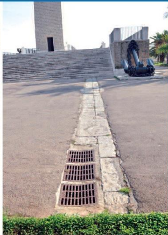
Sfoghi per l'acqua piovana nel piazzale superiore
